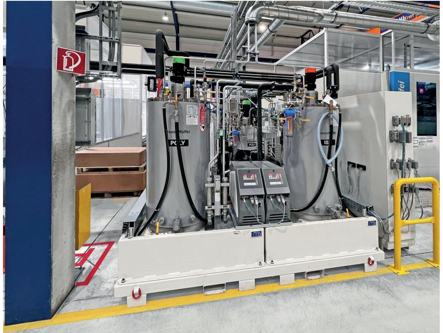
**Bild 3.** Die RimStar Flex Misch- und Dosiermaschine stammt ebenfalls von KraussMaffei. Zwei Mischköpfe MK5-2K CCM sorgen für eine hohe Produktivität der ColorForm-Anlage. © KraussMaffei
